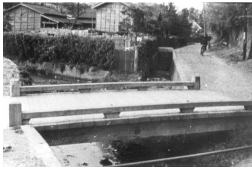
高砂橋(昭和29年)
