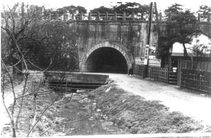
丸子橋架橋のため、 盛り土された中原街道部分に流れていた六郷用水路 上は現在、下は昭和29年の写真
