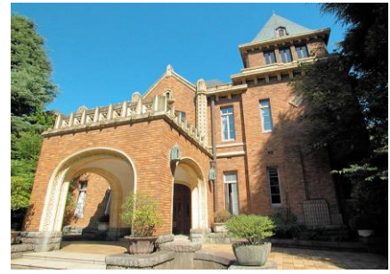
写真5 駒場公園 旧前田侯爵邸
